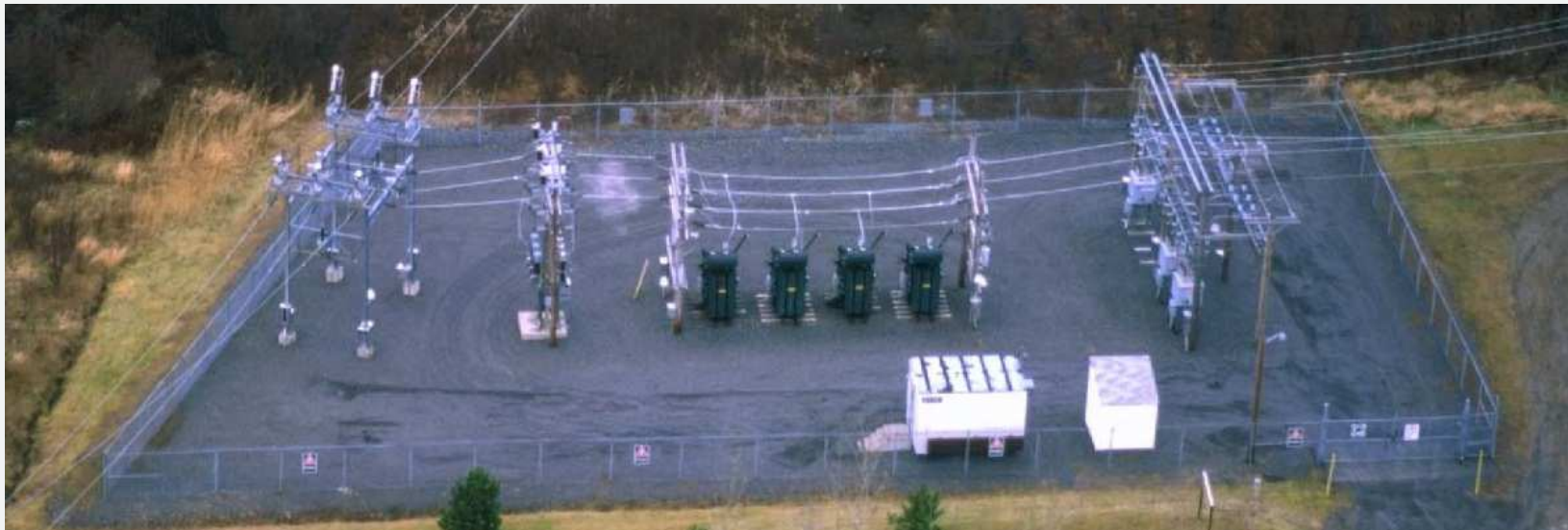
Exemple : poste de Bromont à 49-25 kV
